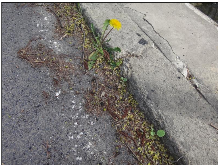
Poruchy říms, uchycená vegetace pod obrubníky
